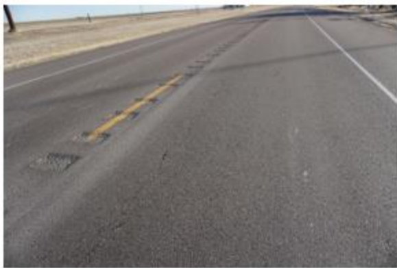
Longitudinal Cracking: 03/07/2017
