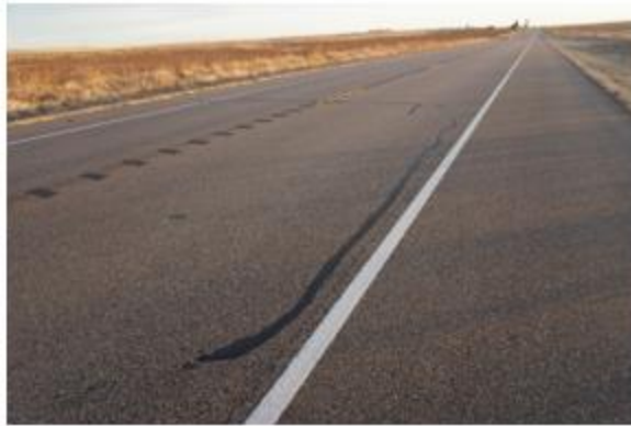
Longitudinal Cracking: 01/10/2018
