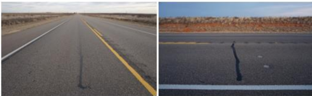
Longitudinal Cracking: 01/10/2018
