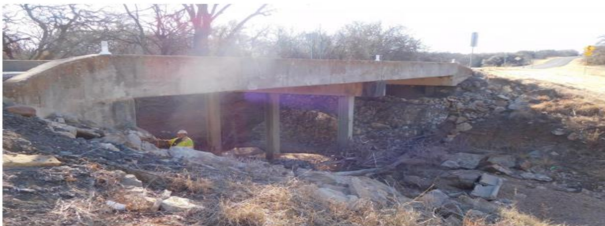
Figure C.25. Bridge CS-13 (TxDOT 2018c)
