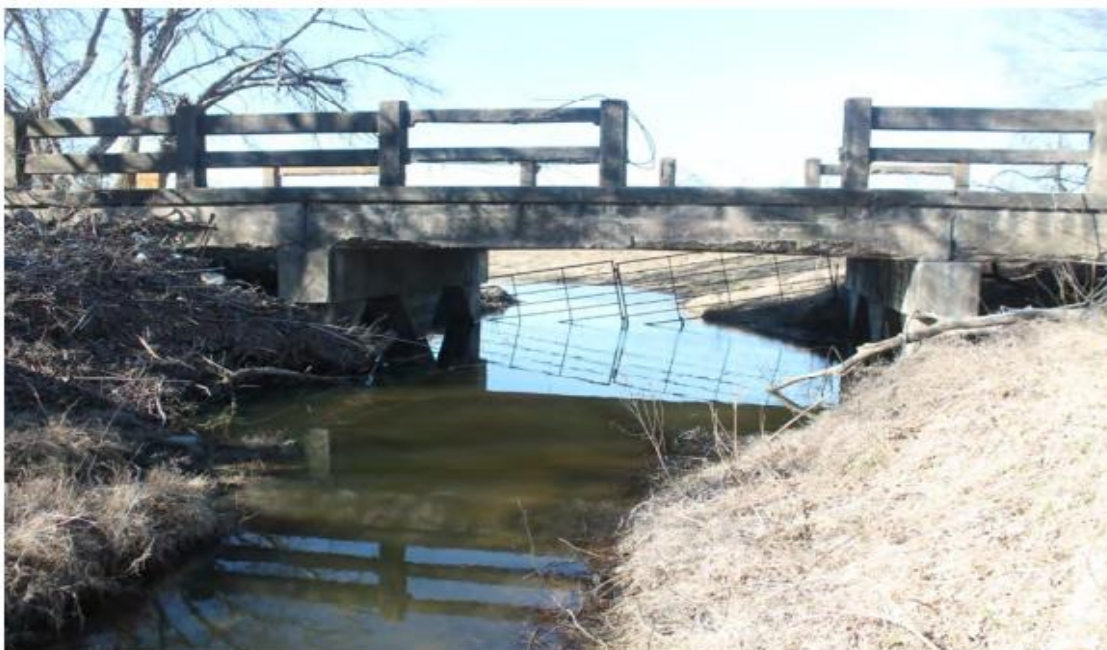
Figure C.5. Bridge CS-3 (TxDOT 2018c)
