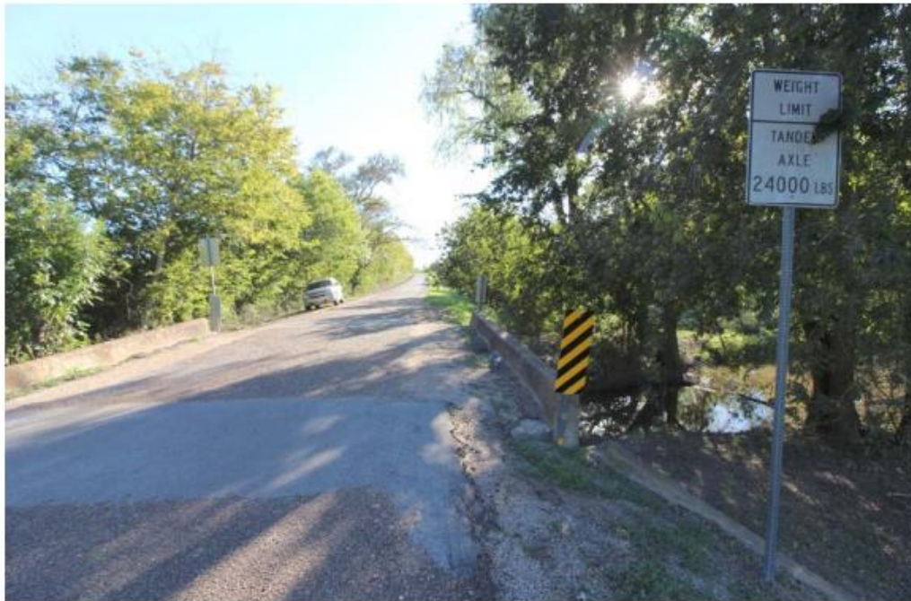
Figure C.11. Bridge CS-6 (TxDOT 2018c)
