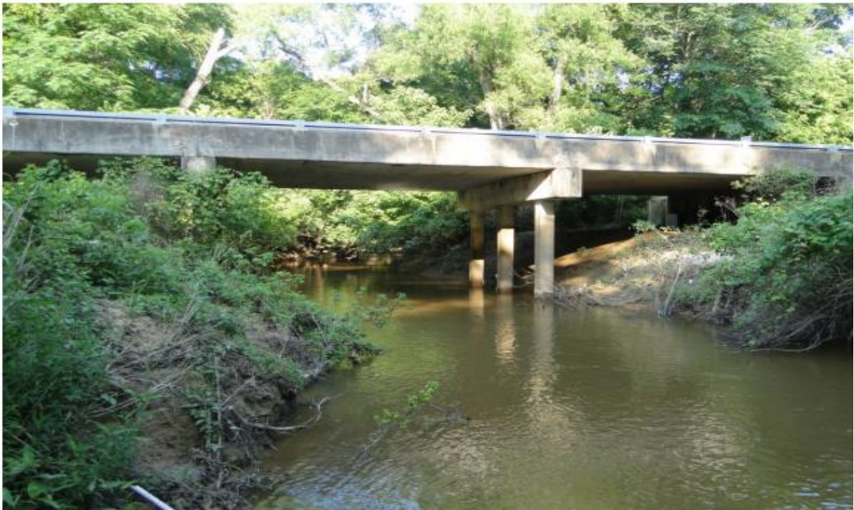
Figure C.27. Bridge CS-14 (TxDOT 2018c)
