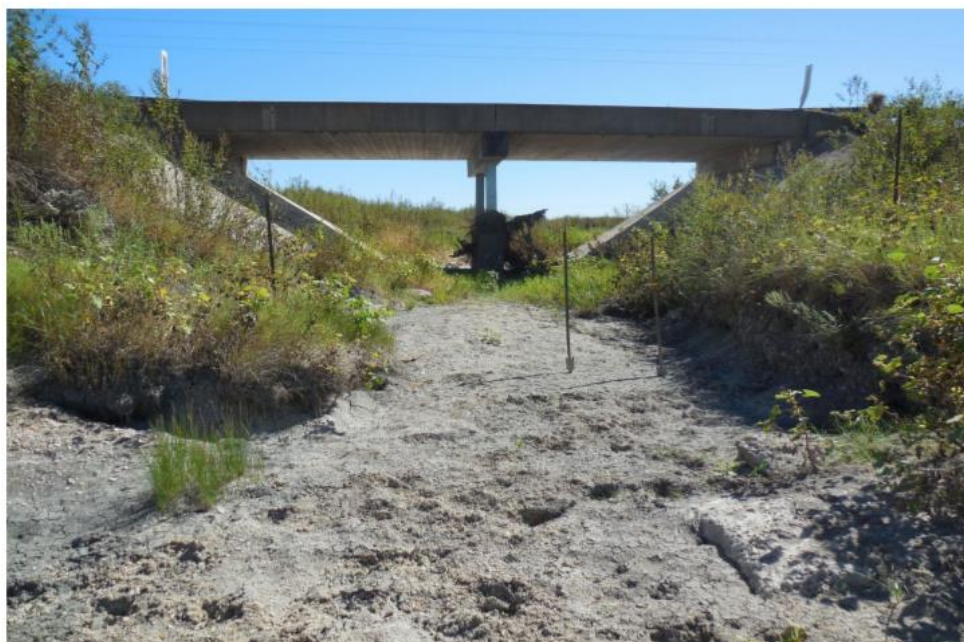
Figure C.23. Bridge CS-12 (TxDOT 2018c)
